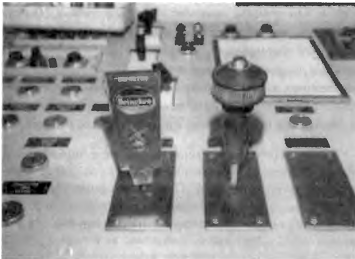
Рис. 4.6. Оригинальные выключатели. Операторы диспетчерской одной атомной электростанции решили проблему похожести выключателей. Они прикрепили к ним ручки с пивных бочонков. Отличный дизайн. Операторы заслуживают награды. (Из Seminara, Gonzales, & Parsons, 1977. Фотографию любезно предоставил Джозеф Л. Семинара)
